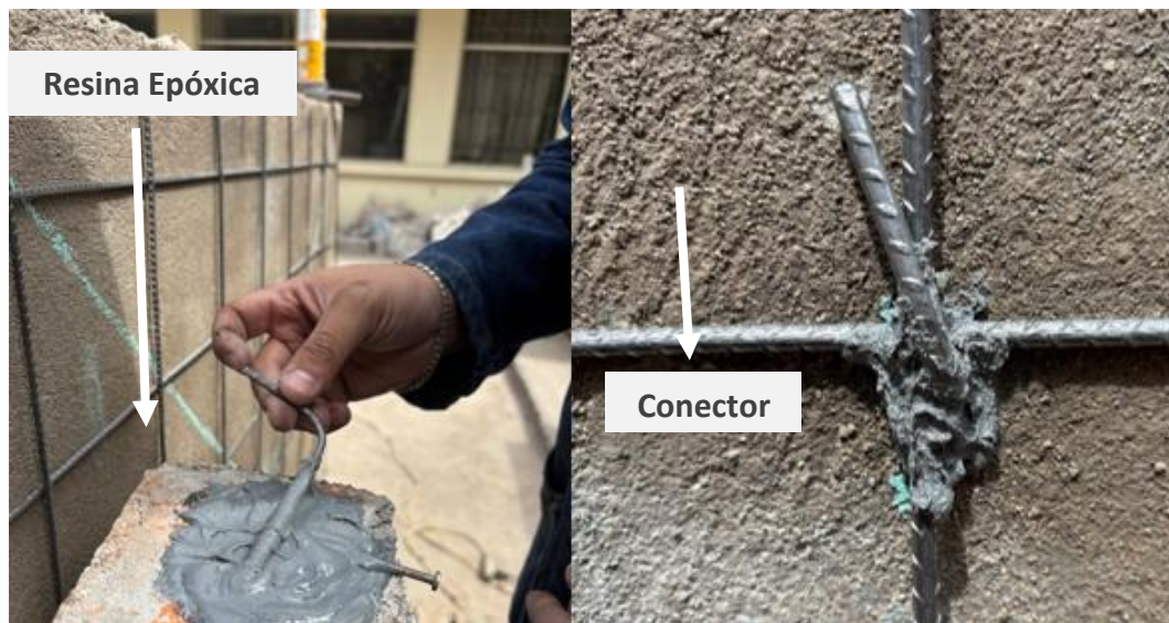
Figura 2. Anclaje de malla por medio de conectores
