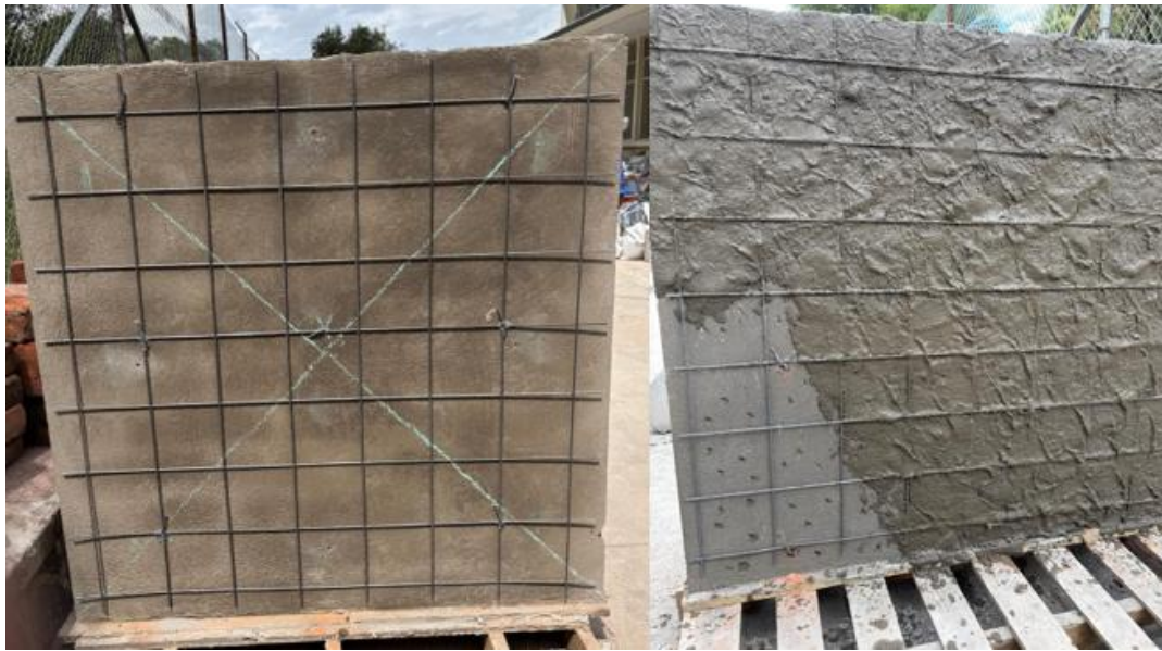
Figura 3. Malla anclada y enlucido final
