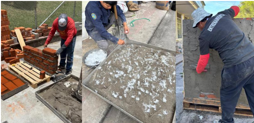
Figura 1. Proceso de construcción de muretes y reforzamiento con FPP
